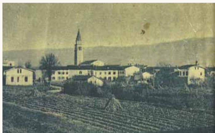
Renče med obema vojnama, pogled na zvonik
