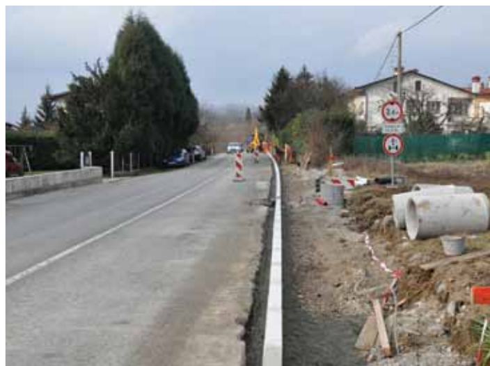
Volčja Draga, izgradnja pločnika ob cesti Volčja Draga-Šempeter
