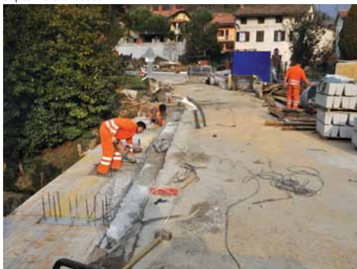
Volčja Draga, širitev mostu čez Bazaršček pri železniških rampah
