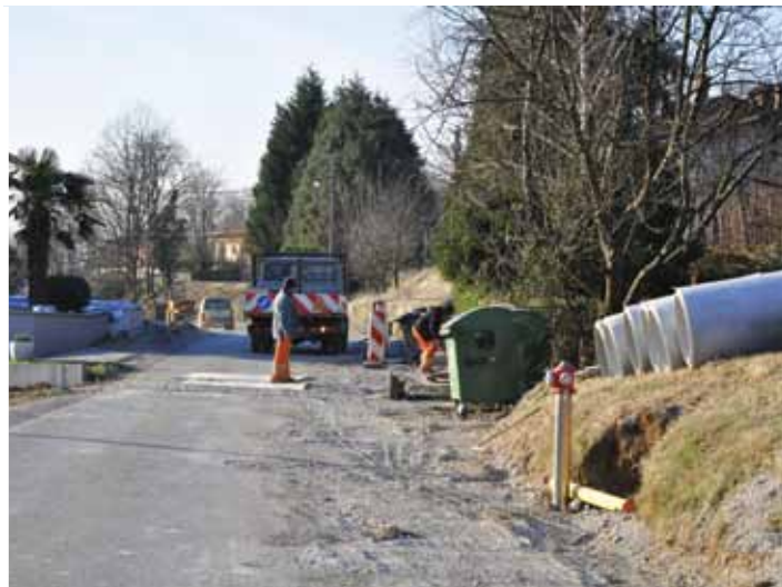
Oševljek, nadaljevanje izgradnje vodovoda Renče-Oševljek
