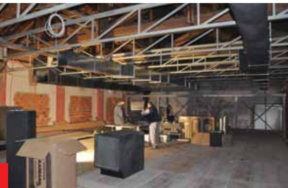
Vgradnja prezračevalno ogrevalnih naprav nad glavno dvorano
