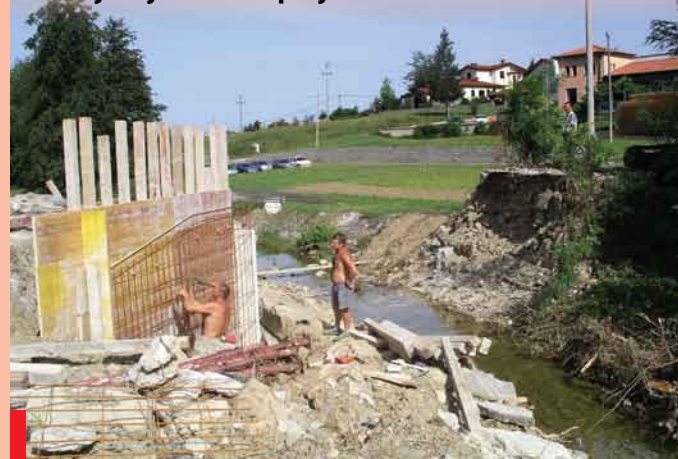
Obnova mostu pri Mohorinih
