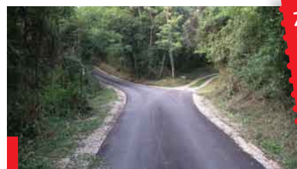
Asfaltiran del cestišča proti zaselku Zarzinišče.
