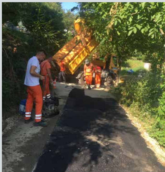
Gradbena dela na vodovodu Mohorini
