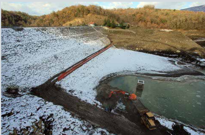
Gradbena dela na akumulacijskem jezeru Vogršček
