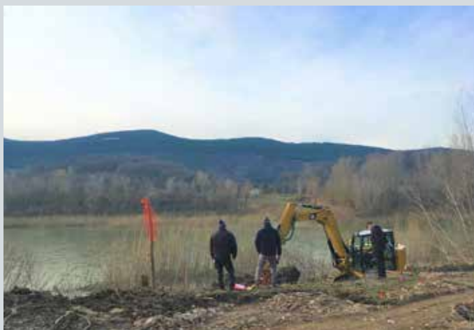
Gradbena dela za ptičjo opazovalnico
