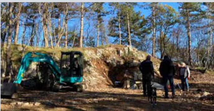
Gradbena dela za ureditev parka
