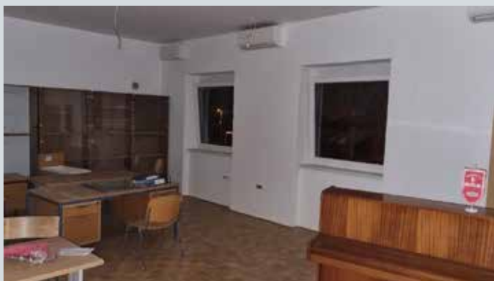
Trenutna dela v notranjosti ZD Vogrsko - manjava oken in elektro inštalacij
