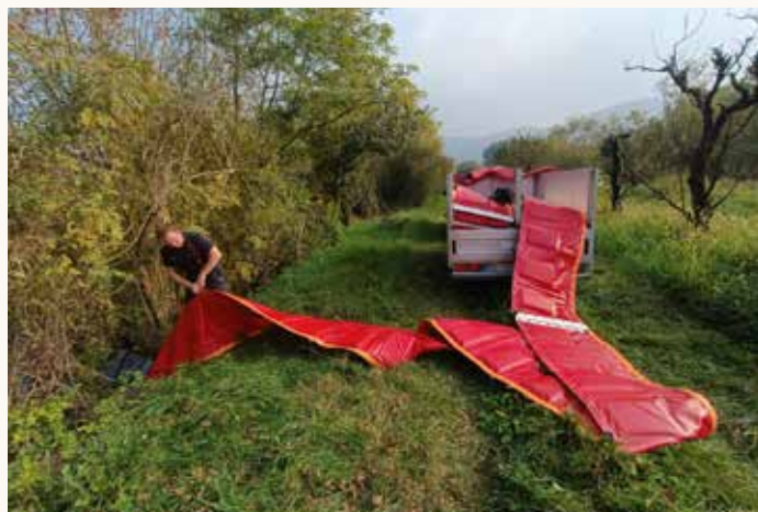
Postavljanje vodne pregrade – jeza.
