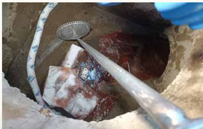
Postavljanje pivnikov v jašek.
