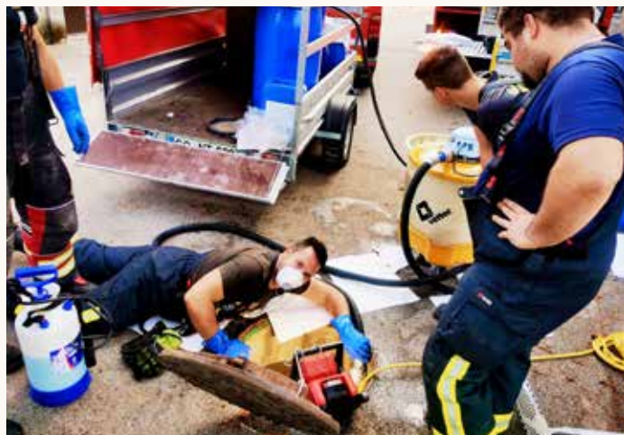
Črpanje kurilnega olja iz jaška.
